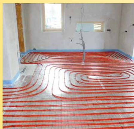
Připravené podlahové topení
